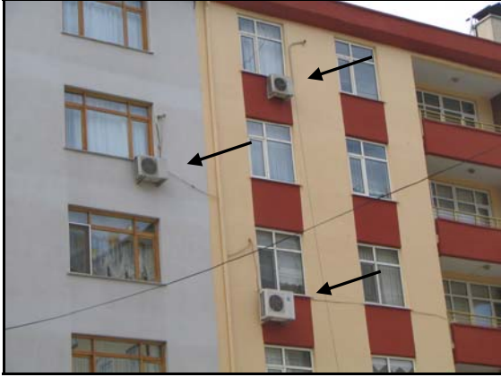
Resim 13. Klima tesisatlarının dış cepheye yansımaları (Korkmaz arşivinden).
