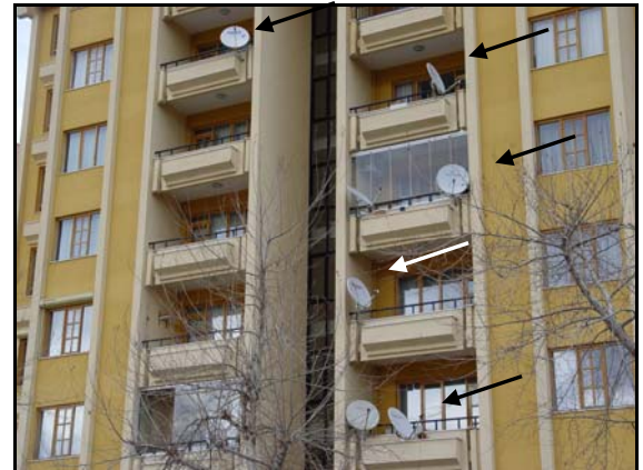
Resim 12. Balkona antenlerin kurulması (Korur arşivinden).
