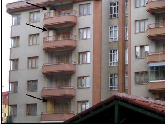
Resim 5. Balkona dolap yaptırılması (Korkmaz arşivinden).
