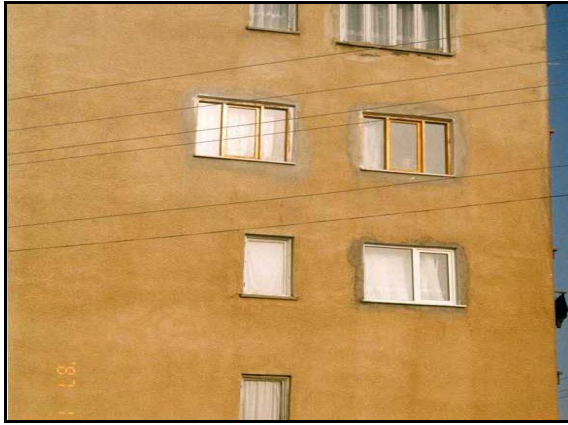
Resim 9. Mekanın sağır cephesine pencere açılması (Korkmaz arşivinden).
