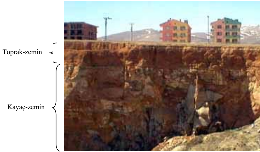
Şekil 4. Konya – Binkonut mahallesinin zemini (yük taşıyıcı ana kayaç-zemin üzerinde bulunan 1 – 3 m kalınlığındaki “toprak-zemin” açıkça görülebilmektedir).
