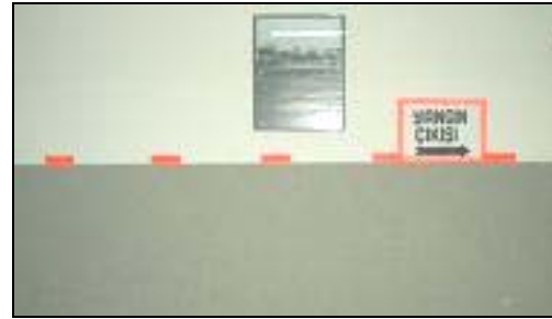
Şekil 5. Görme engelliler için koridorun algılanmasını sağlayan renkli bantlar.
