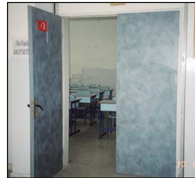
Şekil 13. Engelli kullanıcılar için gerektiğinde çift kanadı açılan kapı örneği. Figure 13. The double winged door for handicapped user.
