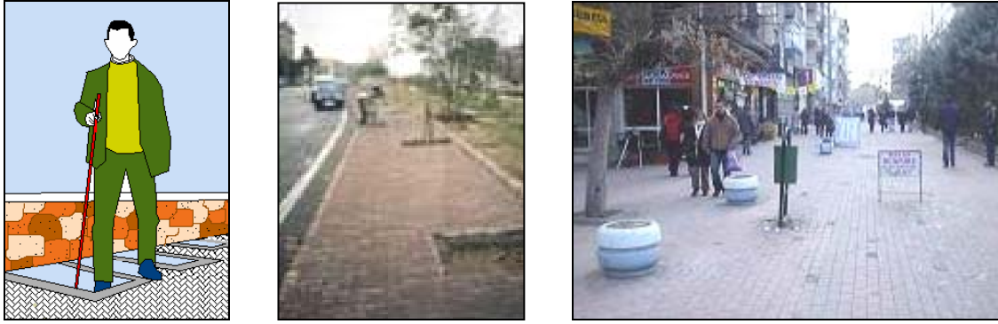
Şekil 3. Görme engelliler için tehlike yaratan çukurlar ve rastgele yerleştirilen elemanlar Figure 3. The holes and irregular elements risk for visually impaired person.
