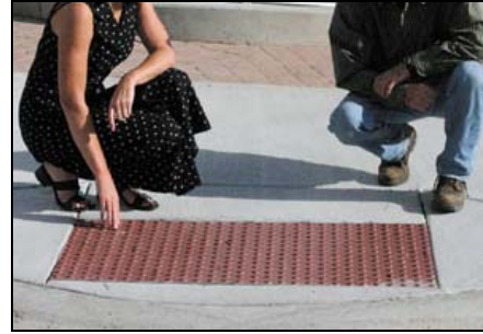
Şekil 12. Rampa üzerinde dokulu kaplama malzemesi uygulaması, Seattle (Goldsmith, 1997). Figure 12. Texture coat material application on the slope (Goldsmith, 1997).
