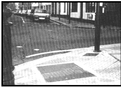
Şekil 12. Rampa üzerinde dokulu kaplama malzemesi uygulaması, Seattle (Goldsmith, 1997). Figure 12. Texture coat material application on the slope (Goldsmith, 1997).
