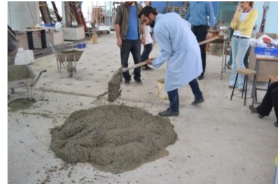
Şekil 4. Deneyde kullanılan çelik telin beton içine karıştırılması (The steel wires mix into the concrete)
