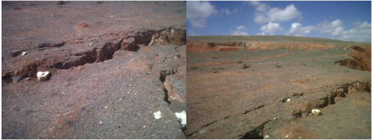
Şekil 2. Arazide oluşan gerilim çatlakları ( Tension cracks formed on the field )
