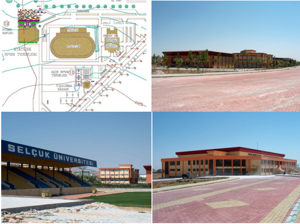
Şekil 11. Spor Tesisleri genel yerleşim (sol üst), 19 Mayıs Spor Salonu (sağ üst), saha tribünü (sol alt), olimpik yüzme havuzu (sağ alt) (Sport facilities (left-top), 19 May Sport Hall (right-top), tribune (left-bottom), swimming pool (right-bottom))(Orjinal2005)
