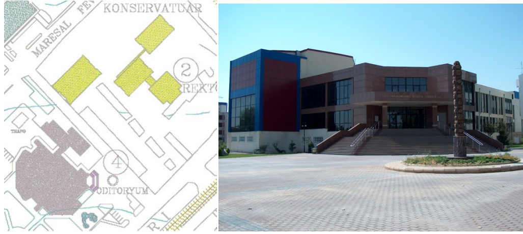
Şekil 12. Süleyman Demirel Kültür Merkezi genel yerleşim (solda), Süleyman Demirel Kültür Merkezi genel görünüm (sağda) (Süleyman Demirel Culture Center location (left), general view (right))(Orijinal 2005)
