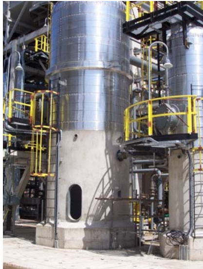
Resim 3. Fireproof Uygulanmış Çelik Yapı.
