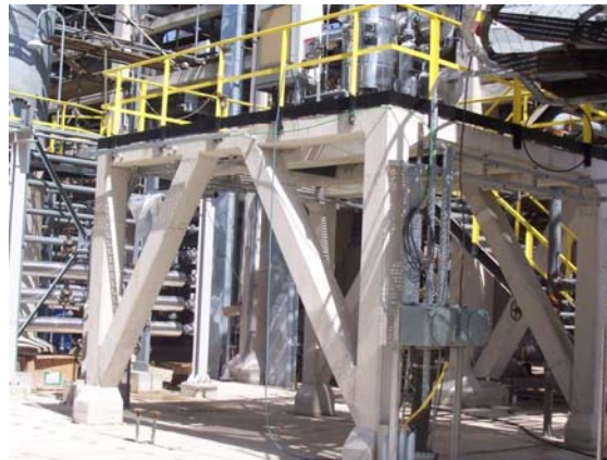
Resim 1. Çelik Profillerin Çelik Hasırla Sarılması.
