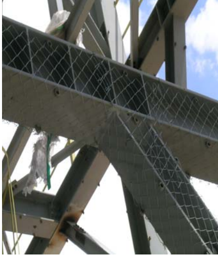
Resim 2. Fireproof Uygulanmış Çelik Yapı.
